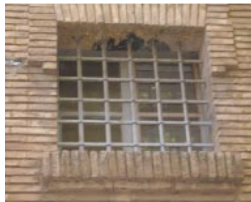
Detalle de una ventana de la cárcel de Torrero
