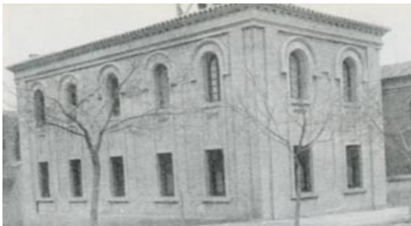
Pabellón de religiosas, construido en 1939 (año de la foto, 1941)
