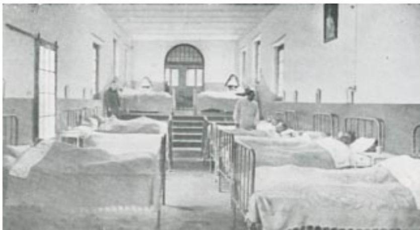
Enfermería provisional de la Prisión Provincial de Zaragoza (año de la foto, 1941)
